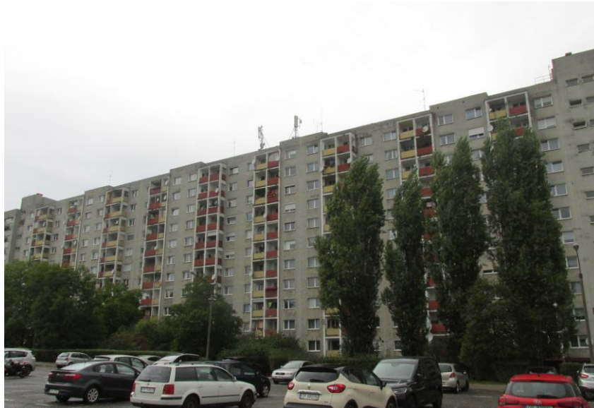
Zał. nr 1: Widok ogólny instalacji radiokomunikacyjnej.
