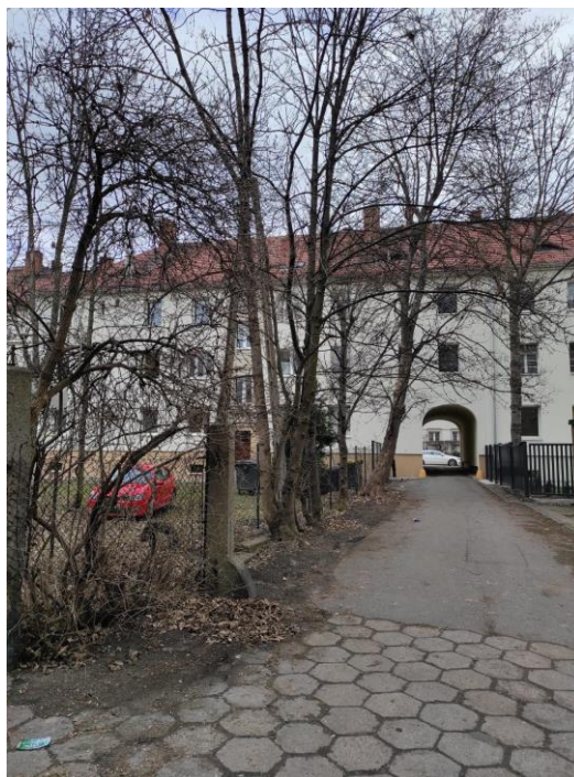
Zadrzewienia przy ciągu pieszym od ul. T. Kościuszki (drzewa rosną tuż przy granicy działki, grunt przy drzewach jest uniesiony, korzenie rozpychają ziemię)
